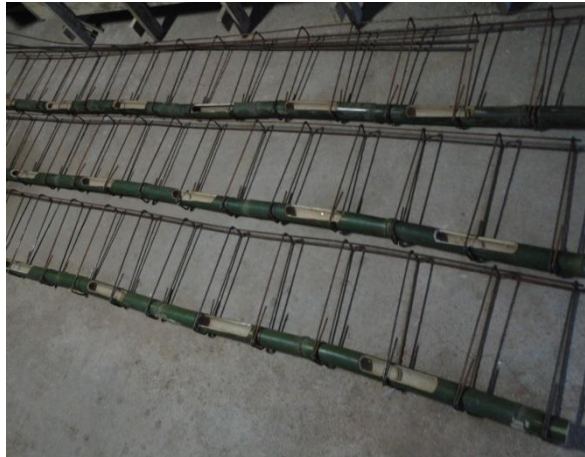
Figura 2: Vigas de bambu com os estribos de aço.
