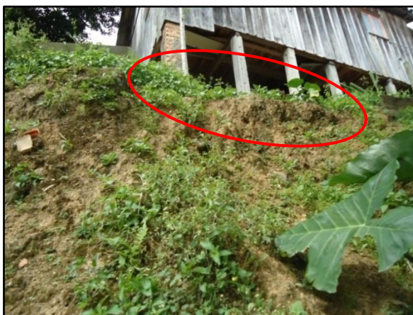
Figura 6 – Casa no topo do talude.
