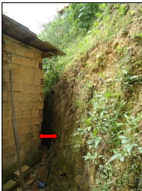
Figura 5 – Casa muito próxima do talude.
