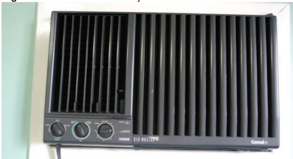
Figura 14 - Ar condicionado de janela com 10.000 BTU
