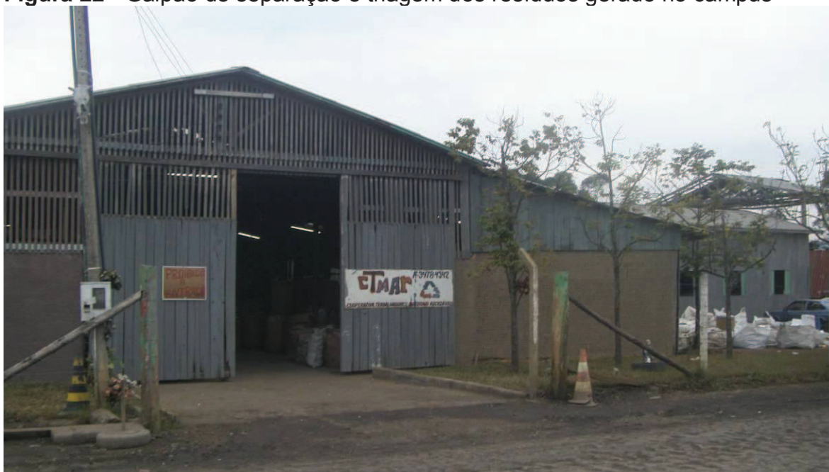
Figura 22 - Galpão de separação e triagem dos resíduos gerado no campus
