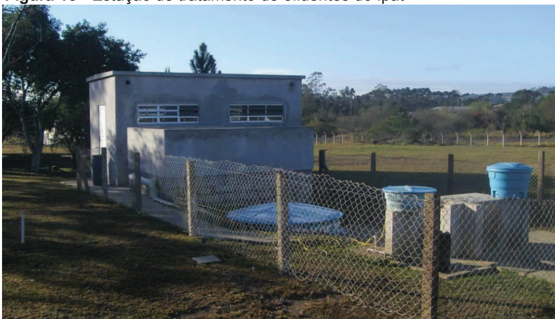
Figura 18 - Estação de tratamento de efluentes do Ipat
