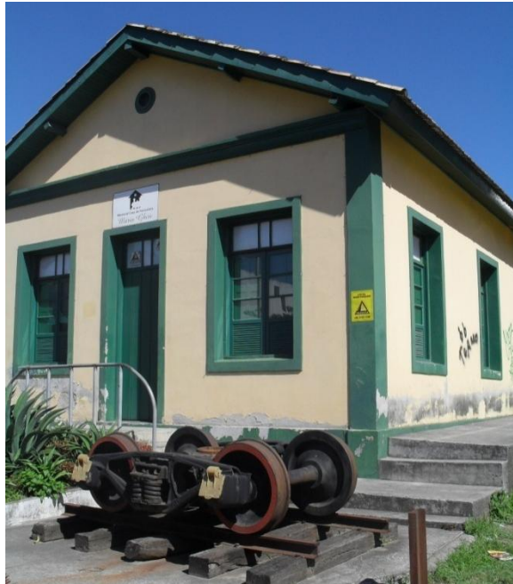
Figura 25 – Memorial casa do Ferroviário Mário Ghisi
