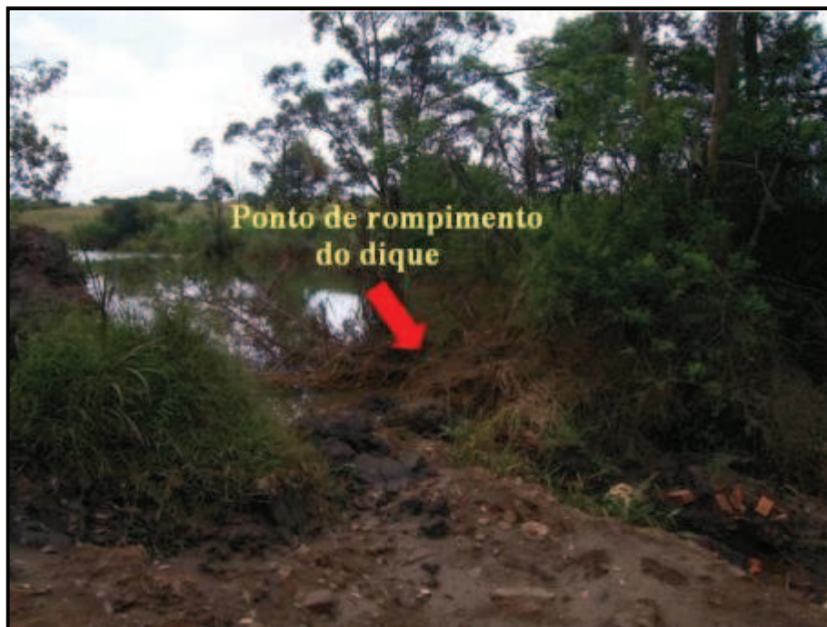
Figura 20 - Rompimento do dique no açude 1, em decorrência do elevado volume de chuva no início do ano de 2010.
