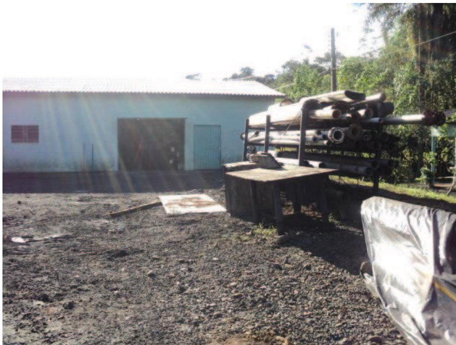
Figura 22: Situação do pátio, diante da oficina da empresa, após a realização da limpeza.
