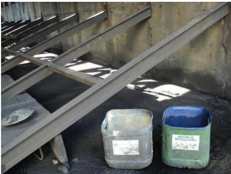
Figura 19: Lixeiras dispostas próximas à Bateria de fornos “D”, sendo que a destinada aos resíduos recicláveis, havia sido utilizada para colocar água, servindo de balde para uma obra nas proximidades.
