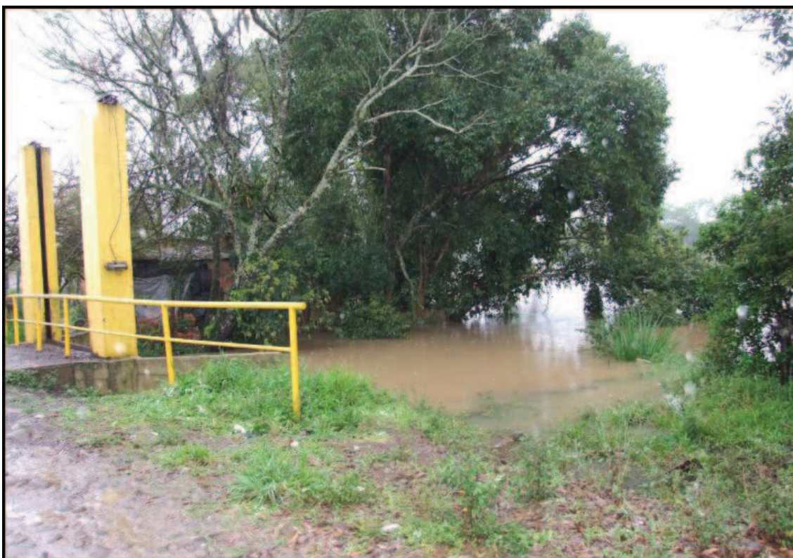
Figura 32: Imagem de uma das comportas localizadas na cidade de Araranguá – SC. Fonte: Google Earth.
