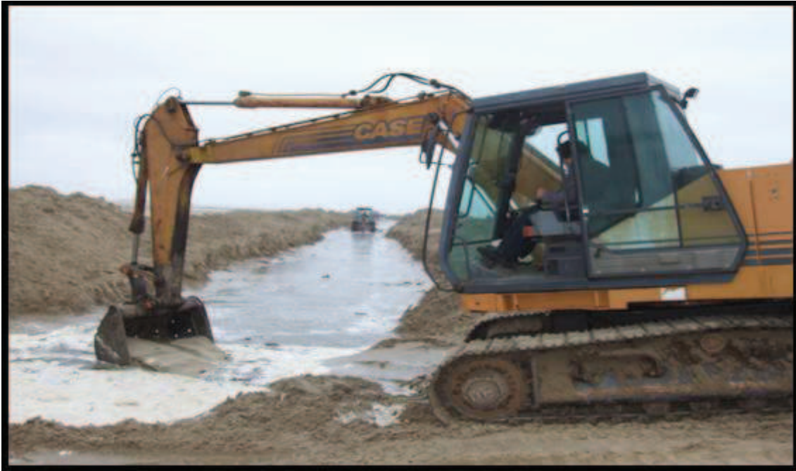
Figura 26: Abertura do canal auxiliar, que facilitou o escoamento das águas do rio Araranguá em direção ao oceano Atlântico. Fonte: Coordenadoria Municipal de Defesa Civil de Araranguá.
