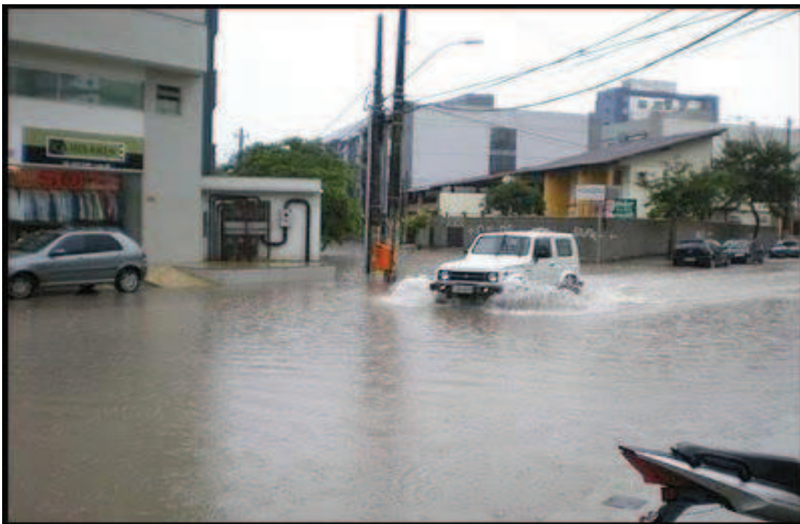
Figura 3: Imagem de área urbanizada no centro da cidade de Araranguá sendo atingida pela enchente, pela falta de permeabilidade e a precária rede de condutos de escoamento. Fonte: Defesa Civil Municipal de Araranguá (2010).
