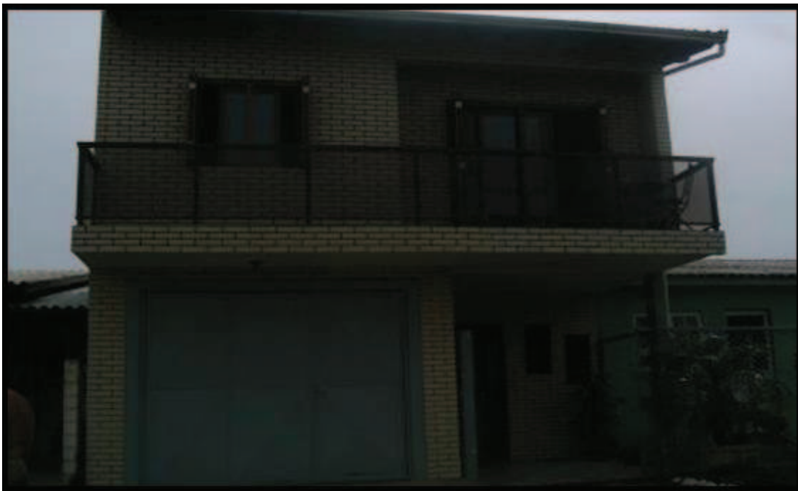
Figura 33: Residência de dois pisos no bairro Barranca como medida mitigadora, em casos de enchente. Se necessário é feita a transferência dos móveis e pertences para o andar de cima e uma maior segurança aos moradores. Fonte: (BATISTA, 2011).
