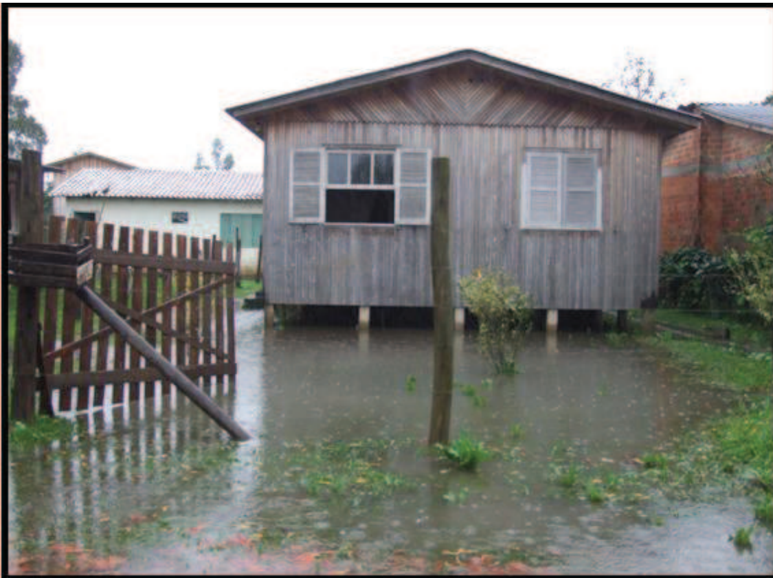
Figura 34: Elevação de uma residência do bairro Barranca como medida mitigadora, dando assim, uma maior margem de segurança aos moradores. Fonte: Sandro Ramos (2009).
