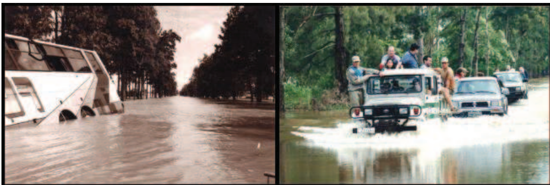
Figura 24: BR – 101, atingida pela enchente na cidade de Araranguá do ano de 1995. Fonte: Coordenadoria Municipal de Defesa Civil de Araranguá.
