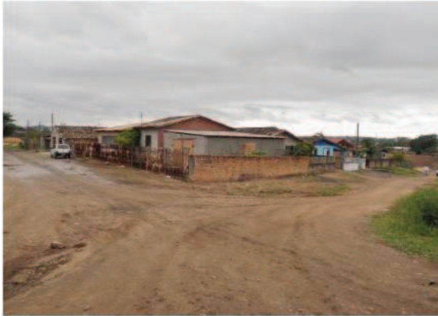
Figura 11: Falta de pavimentação no PE 3.
