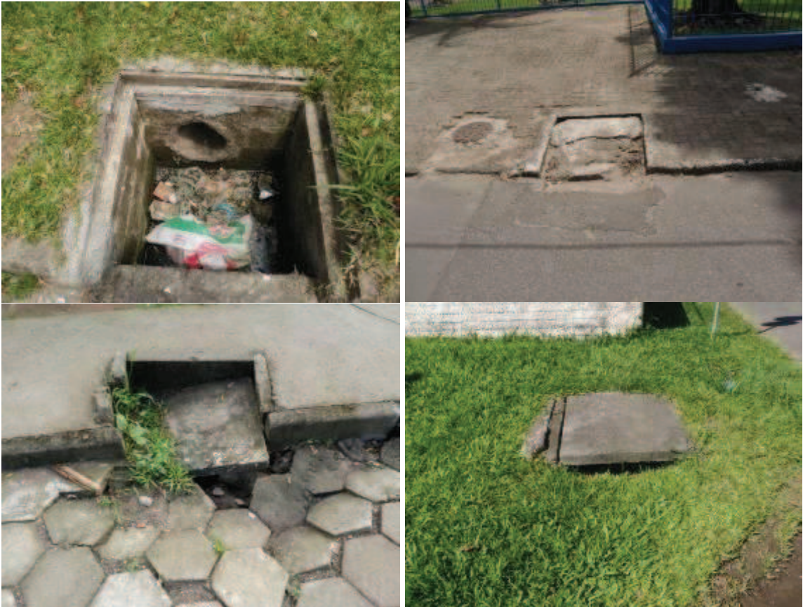
Figura 13: Falta de manutenção no sistema de microdrenagem.
