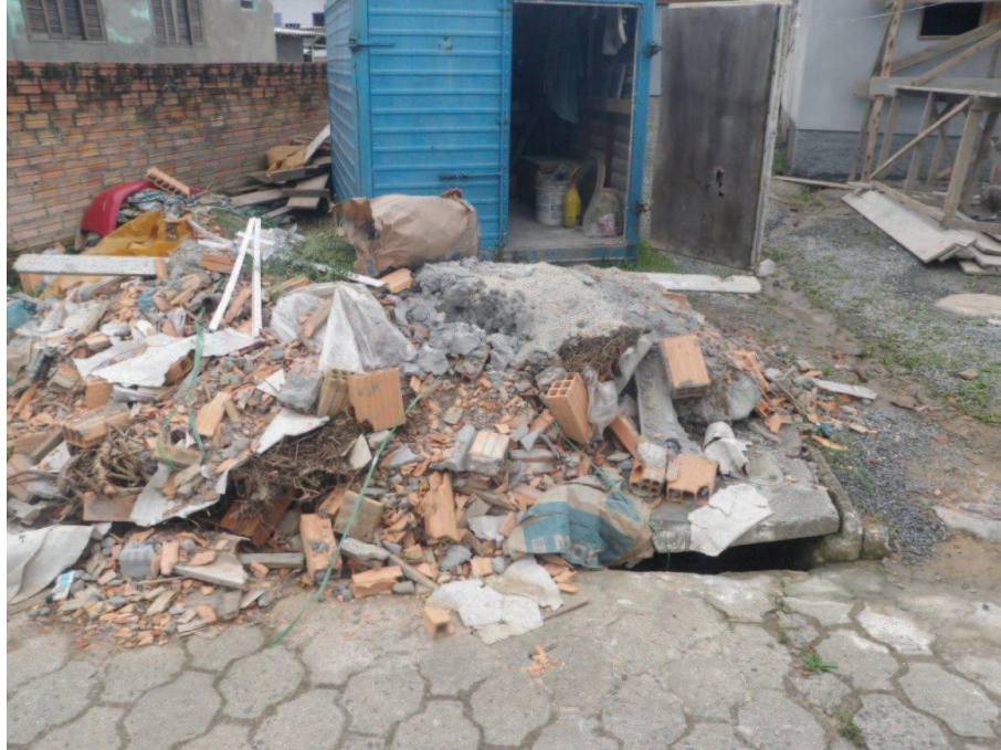
Figura 15: Disposição de RCC sobre a guia na Rua José Zanette.
