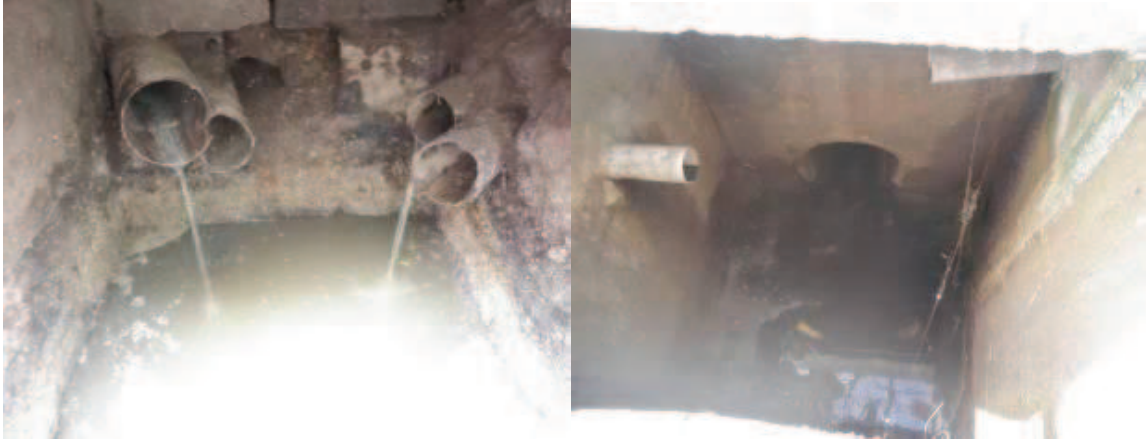
Figura 21: Lançamento de esgoto nas guias.
