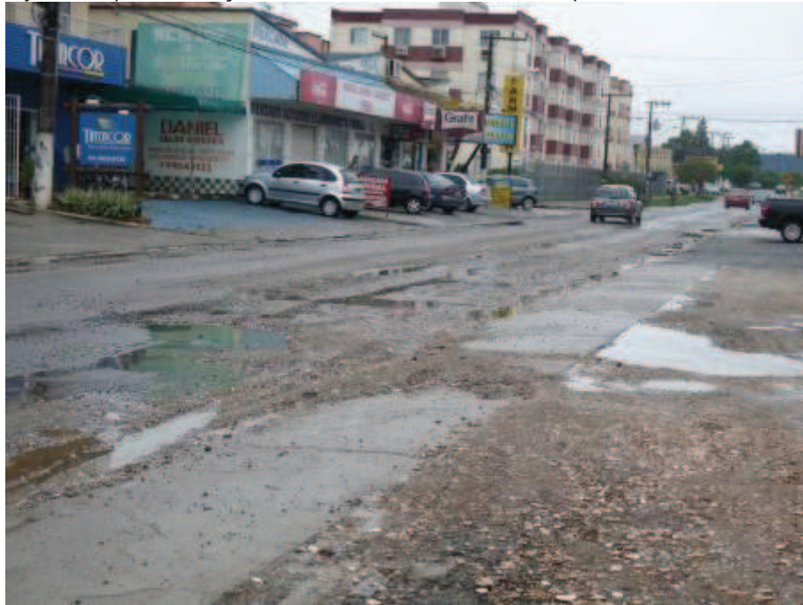
Figura 24: Prejuízos à pavimentação da avenida Santos Dumont após chuva intensa.
