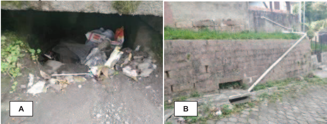
Figura 28: A) Disposição de resíduos na microdrenagem. B) Lançamento de esgoto doméstico na rede de drenagem pluvial.
