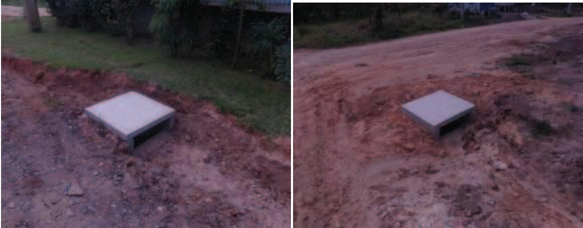
Figura 18: Sedimentos obstruindo o sistema de microdrenagem.
