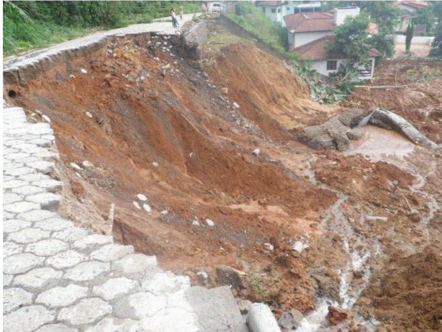
Figura 45: Deslizamento de encostas.
