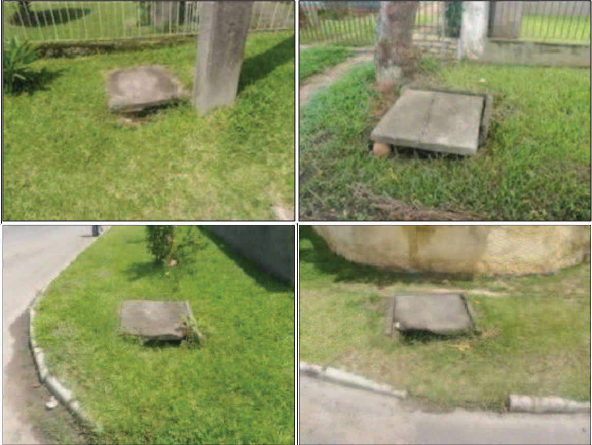
Figura 7: Guias fora do percurso de escoamento da água superficial.
