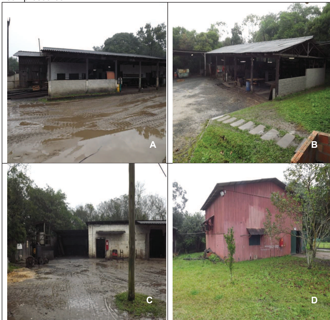
Figura 17 - A) Oficina mecânica; B) Caldeiraria; C) Lavação D) Sala de compressores
