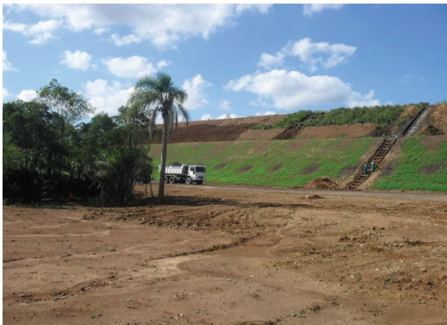
Figura 12 - Área de rejeitos 03, início da cobertura vegetal e construção das drenagens (2011).
