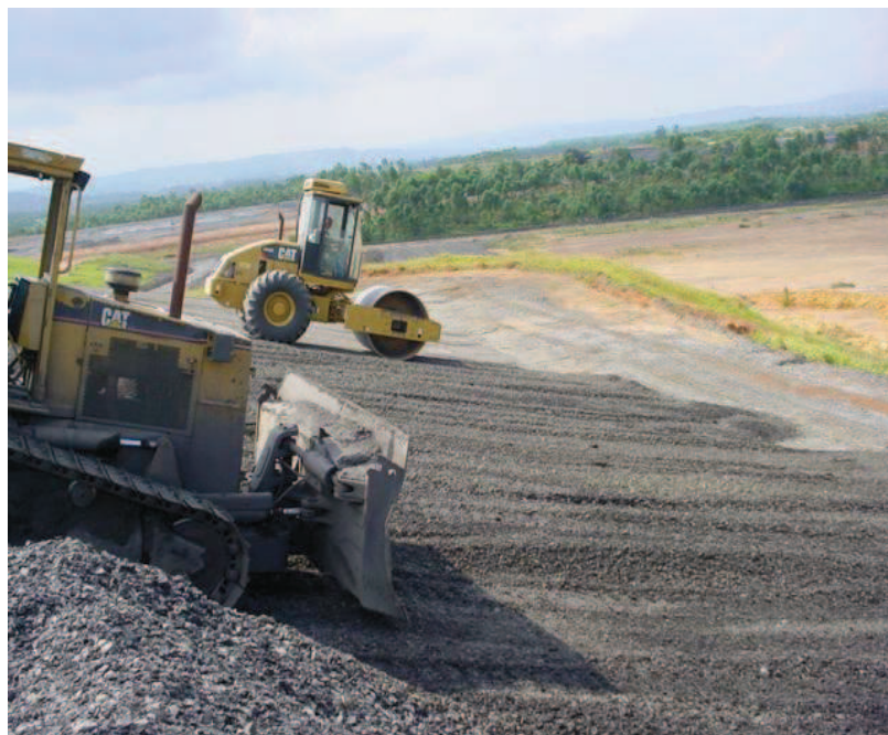
Figura 10 - Conformação e compactação do depósito de rejeitos com o auxílio do rolo compactador e trator esteira (2009).
