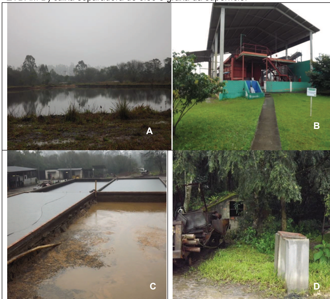
Figura 16 - A) Bacia de decantação dos sólidos sedimentáveis; B) ETDAM estação de tratamento de drenagem ácida de mina; C) Bacia de secagem do lodo da ETDAM D) caixa separadora de óleo e graxa da superfície.
