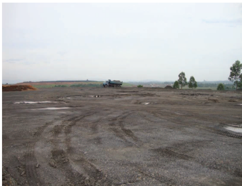
Figura 11 - Área de rejeitos 03, cobertura da área com material argiloso (2010).
