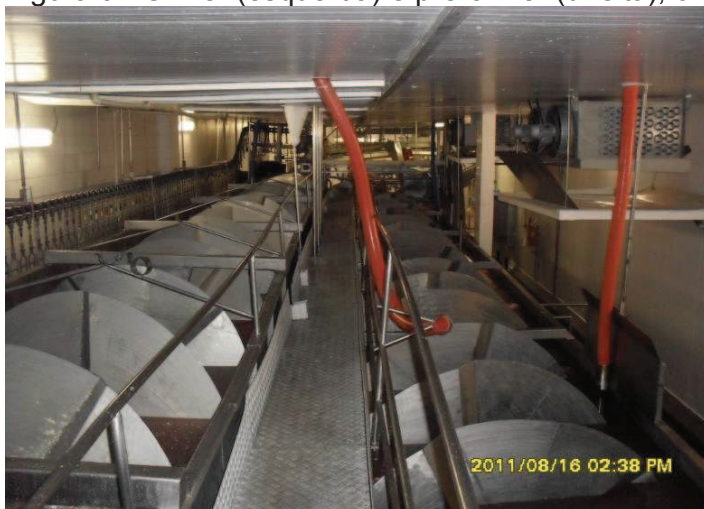
Figura 9 - Chiller (esquerda) e pré-chiller (direita), onde o frango é resfriado.
