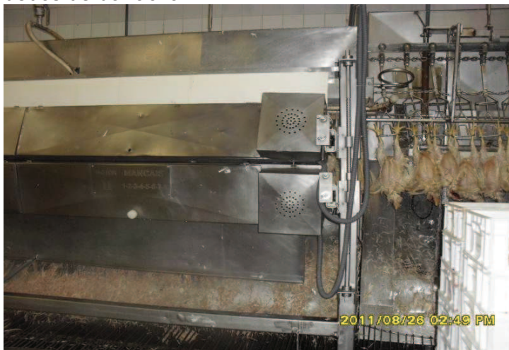
Figura 7 - Equipamento onde a pena dos frangos é retirada através da fricção de dedos de borracha.
