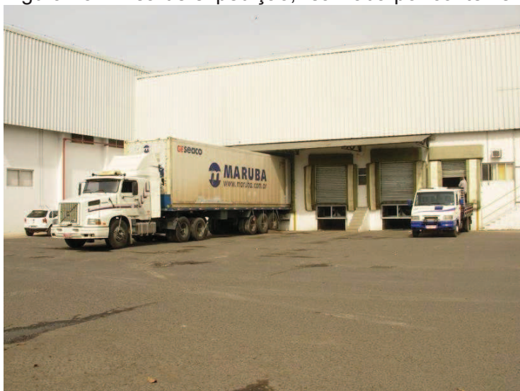
Figura 13 - Área de expedição, realizada por contêineres.
