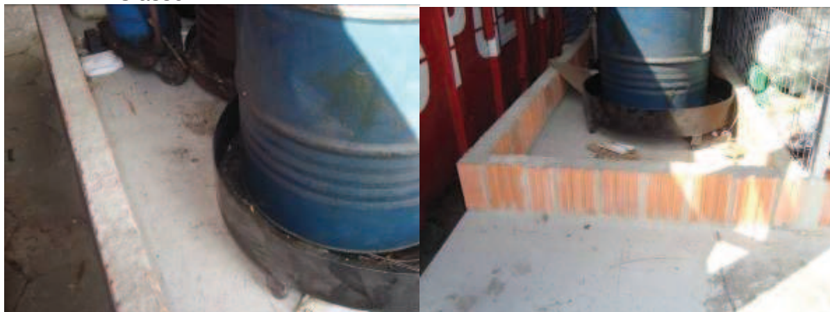
Figura 21 - Contenção de concreto construídas na empresa nos boxes de resíduos Classe I.
