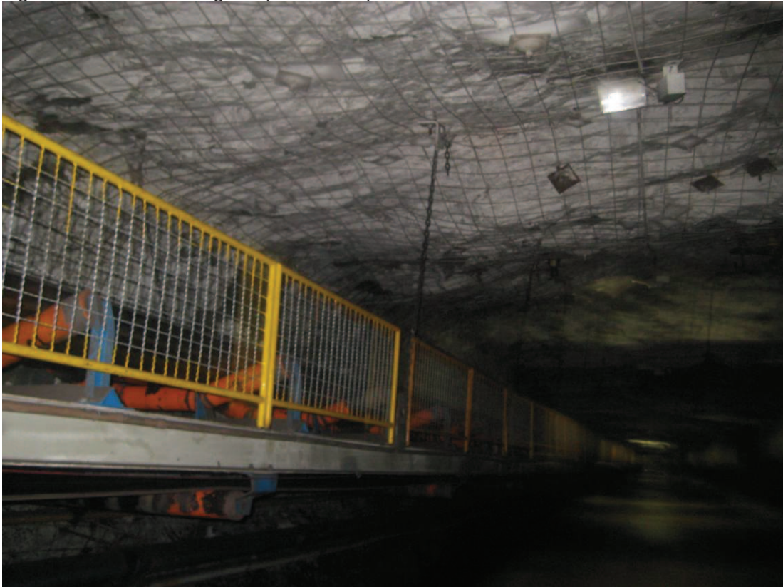
Figura 30 - Grades de segurança no teto e paredes da mina.
