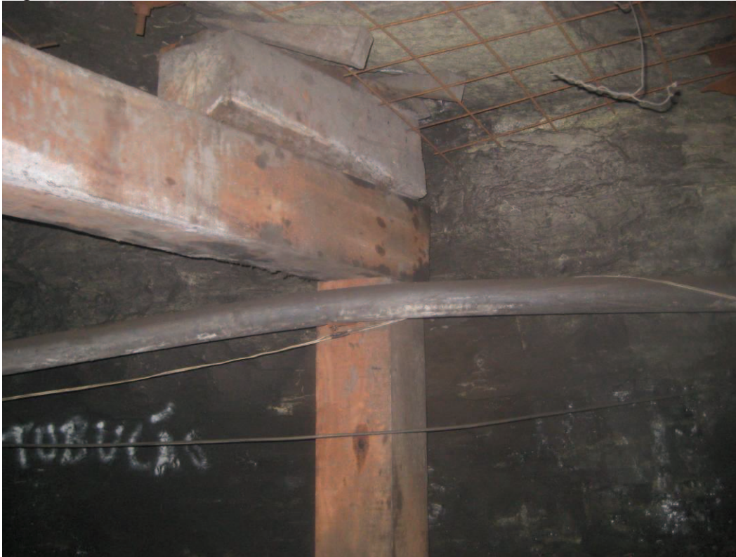
Figura 28 - Escoramento do teto com madeira.
