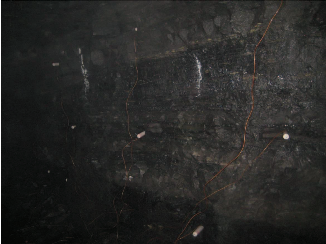
Figura 20 - Pavios conectados aos explosivos
