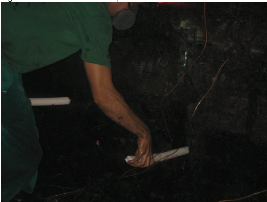
Figura 19 - Posicionando os explosivos nos furos.
