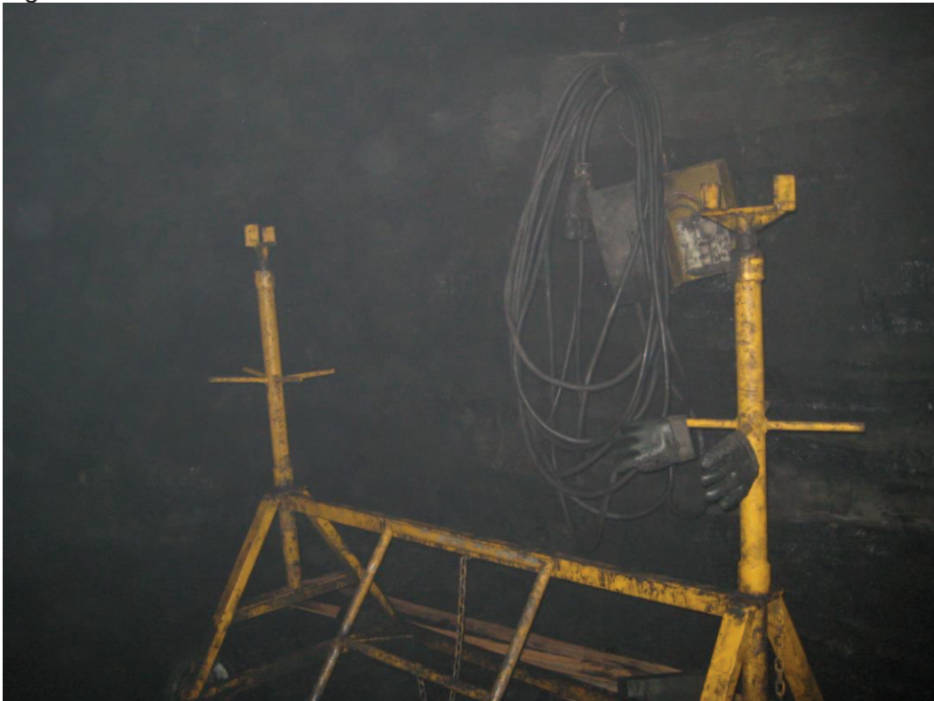
Figura 27 - Macaco utilizado no escoramento de teto com madeira.
