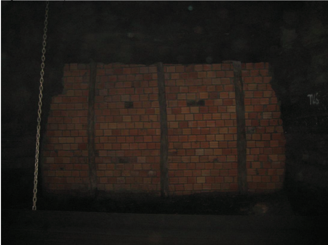
Figura 29 - Tapume de alvenaria.
