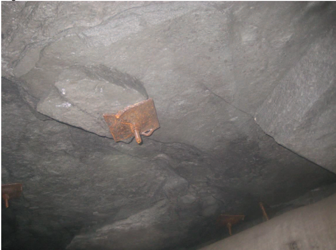
Figura 13 - Escoramento de teto.
