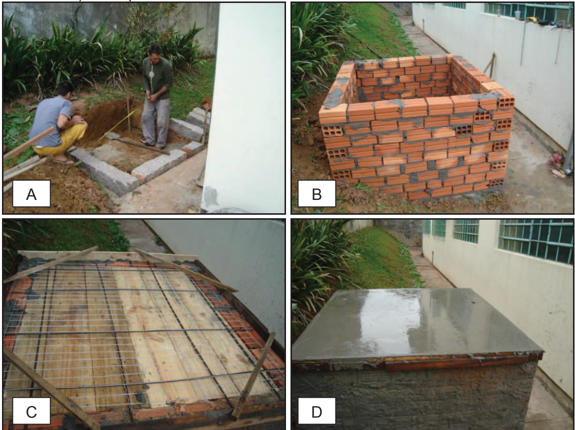
Figura 40: A ao C) Base para o tanque de armazenamento de água da chuva sendo construído D) Base pronta
