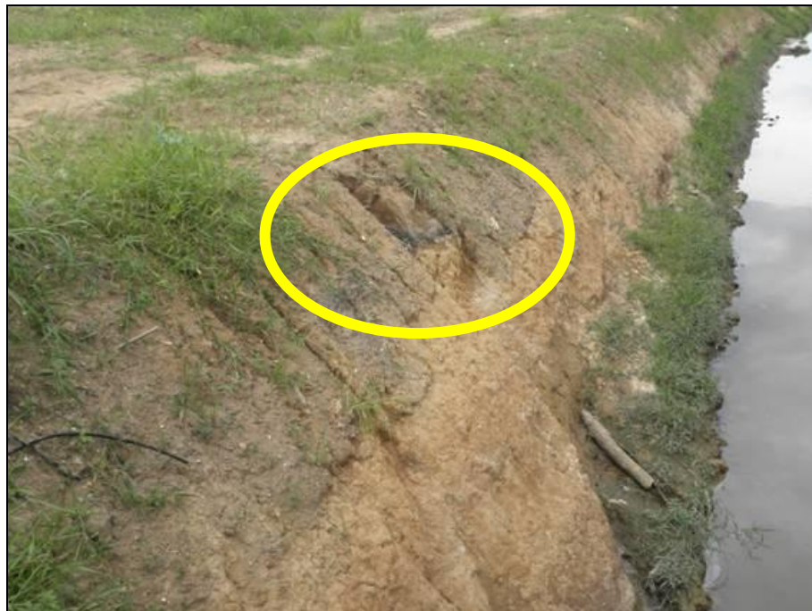
Figura 7 - Vista parcial da margem direita do rio Criciúma, a jusante da ponte sobre a Rua Olívio Antunes (bairro Santo Antônio), onde se observa áreas pontuais com a presença de rejeitos carbonosos (área em destaque).
