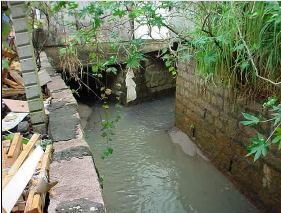
Figura 12 - Vista do rio Criciúma entre as ruas Henrique Lage e Cônego Miguel Giacca. Observa-se a canalização do curso d'água com paredes de pedra e construção em sua APP.
