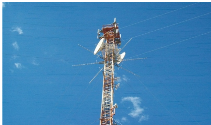
Figura 02 – Torre Estaiada de Seção Quadrada
