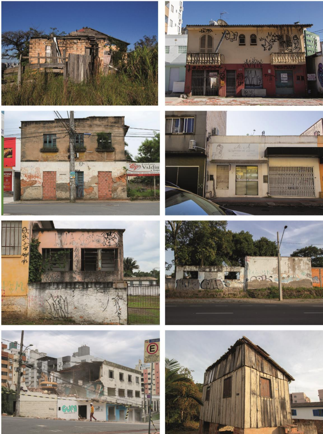
Imagem 15 – Lugares em ruínas na cidade de Criciúma/SC
