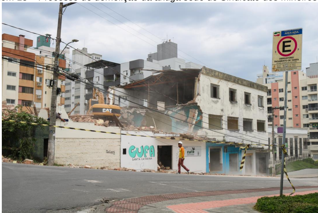
Imagem 13 – Processo de demolição da antiga sede do Sindicato dos Mineiros
