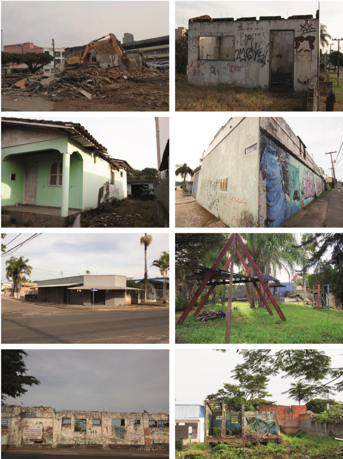
Imagem 16 – Lugares em ruínas na cidade de Criciúma/SC
