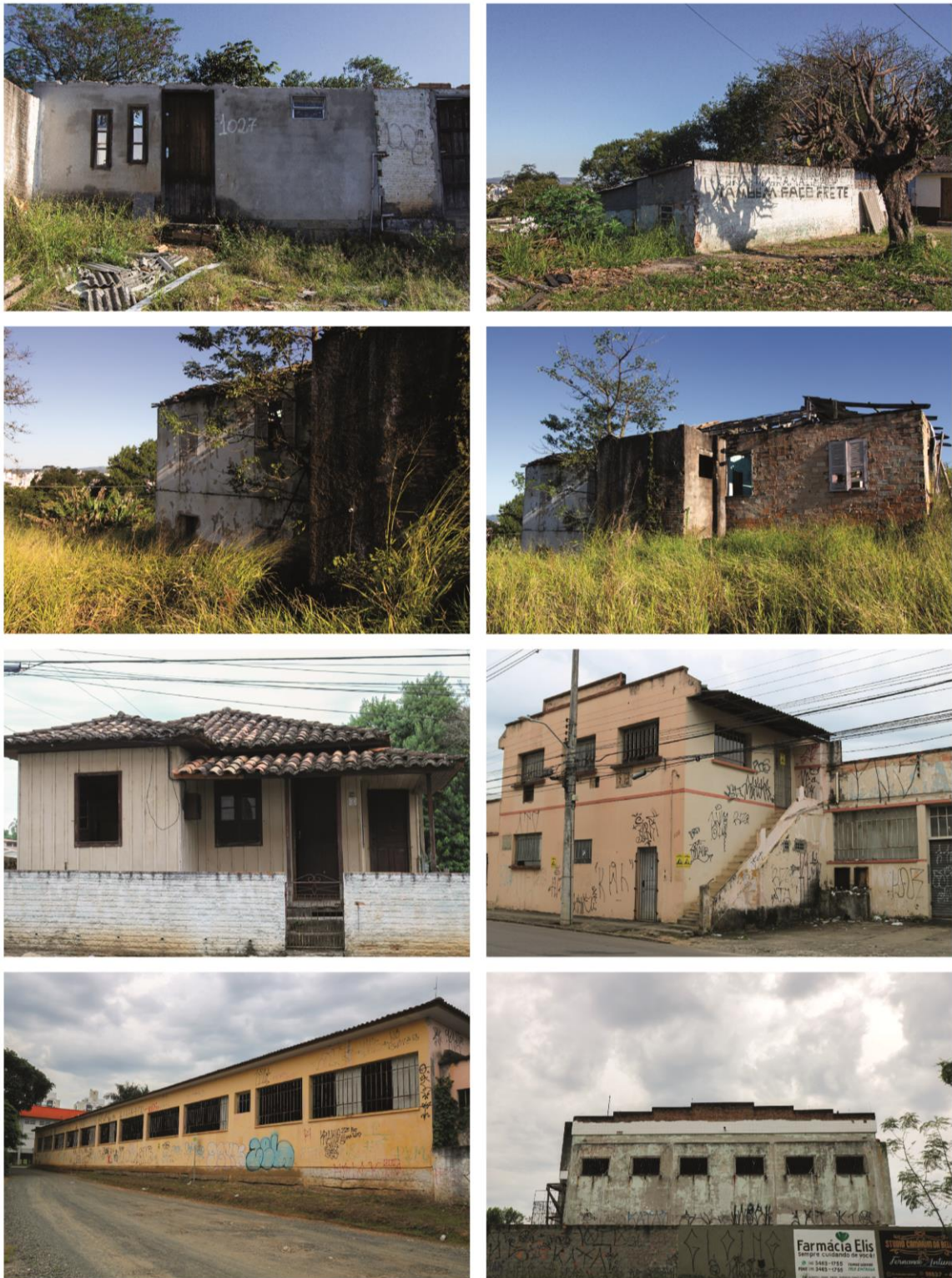
Imagem 14 – Lugares em ruínas na cidade de Criciúma/SC
