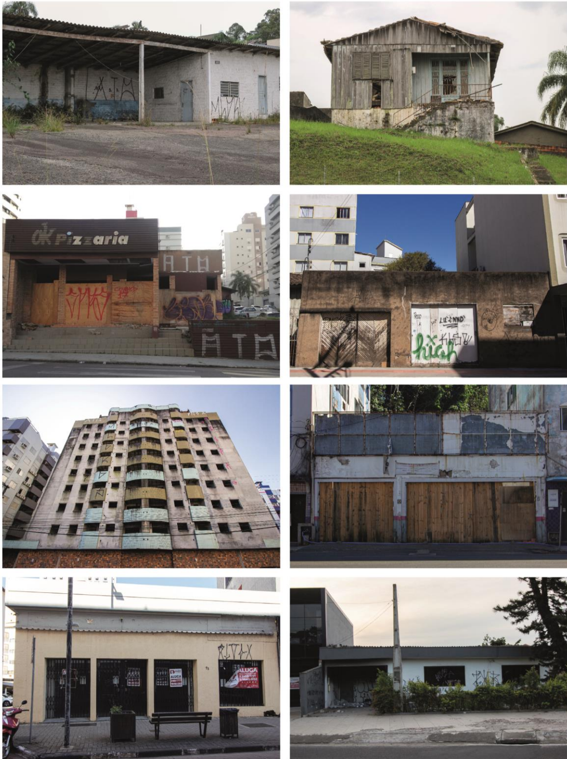
Imagem 17 – Lugares em ruínas na cidade de Criciúma/SC
