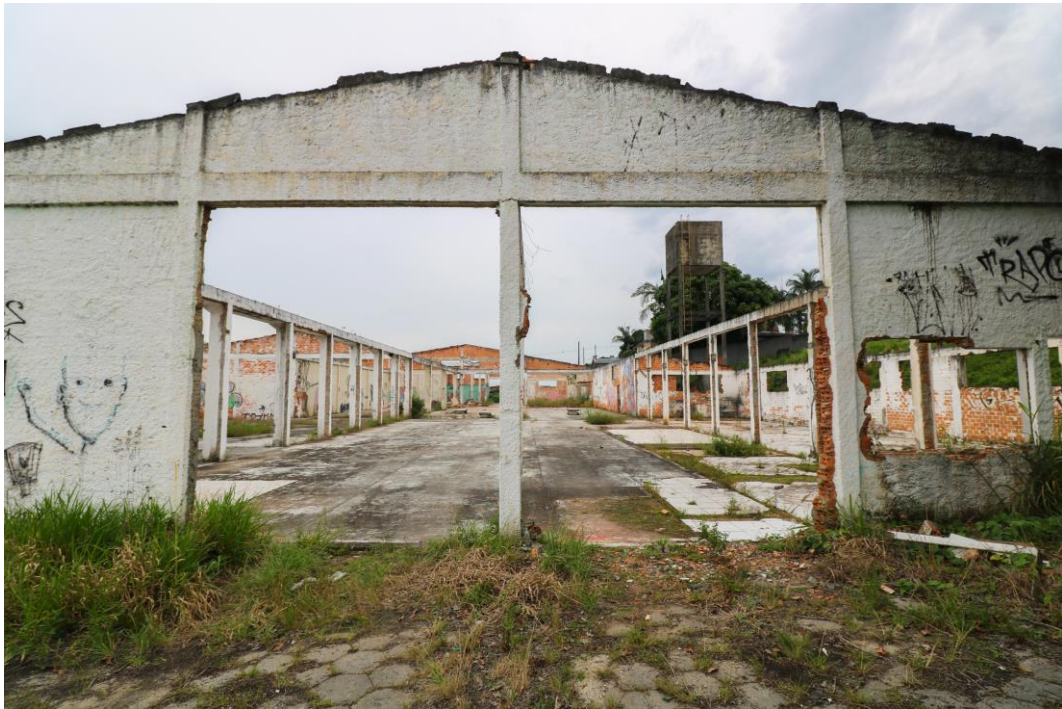
Imagem 18 – Visão frontal da fábrica abandonada
