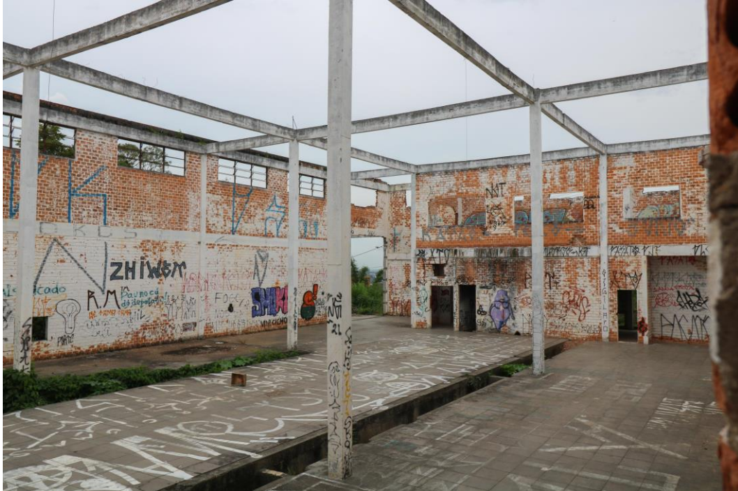
Imagem 19 – Visão interna da fábrica abandonada
