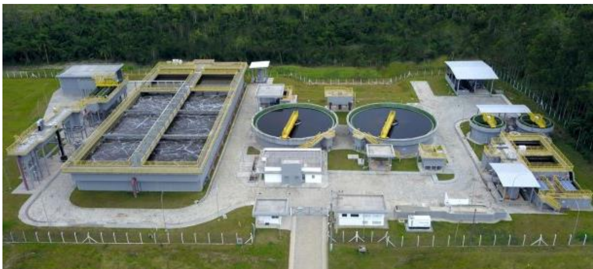
Figura 1: Visão aérea de uma Estação de Tratamento de Esgoto da CASAN.
