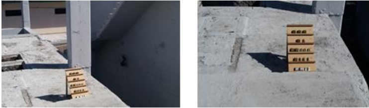
Figura 23 - Estande de teste de resistência ao intemperismo natural.
