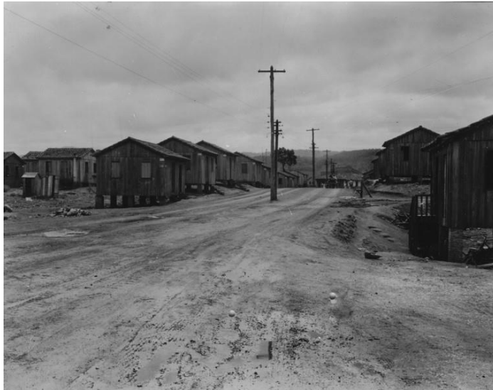
Figura 2- Rua do bairro Rio Fiorita
