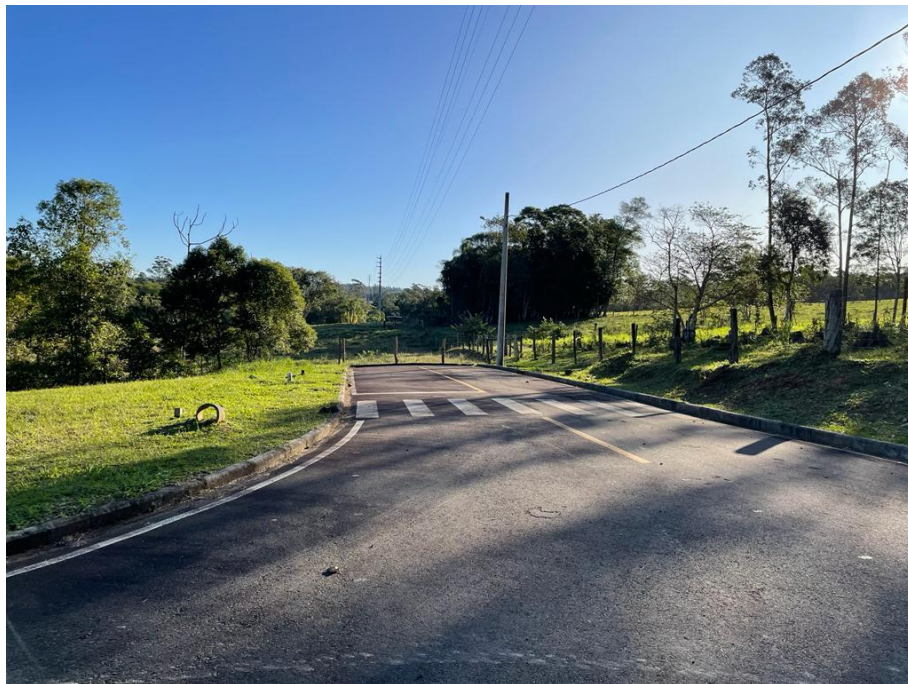
Figura 06 – Rua E do Loteamento Niero projetada com largura de 12 metros para o prolongamento
