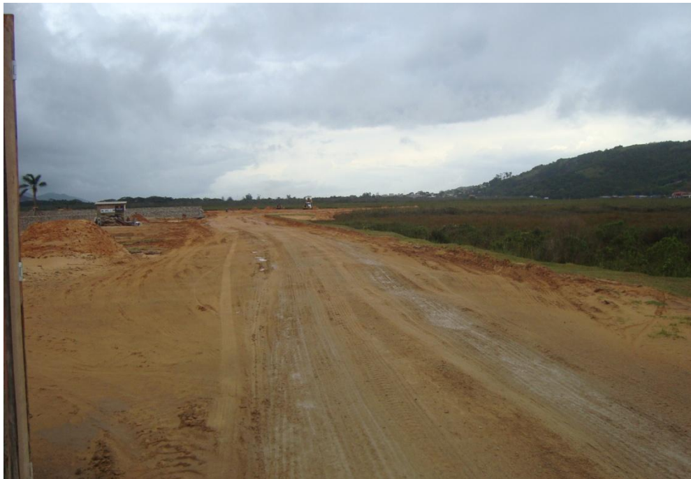
Fig. 02: Vista geral de estrada de acesso aberta na área do empreendimento imobiliário do Banhado da Palhocinha, Garopaba,SC.
