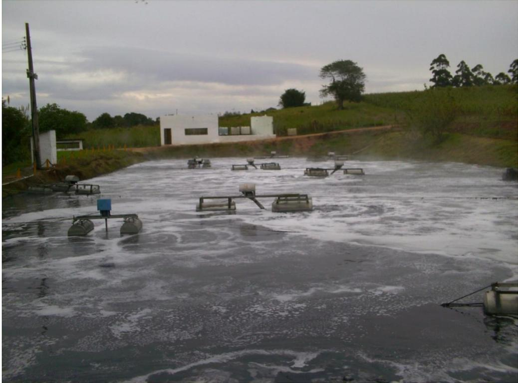
**Figura 09:** Vista dos aeradores da lagoa de aeração da Indústria Têxtil objeto do estudo de caso, Içara/ SC.
