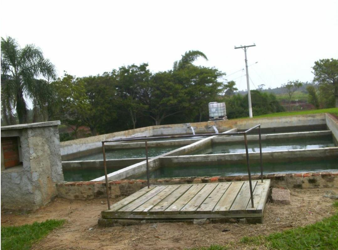
**Figura 05:** Vista parcial do tanque de coagulação/floculação/decantação da Indústria Têxtil objeto do estudo de caso, Içara/ SC.
