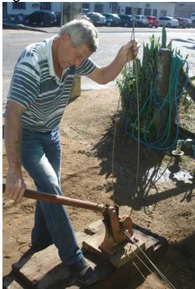
Figura 11: Corte dos ferros
